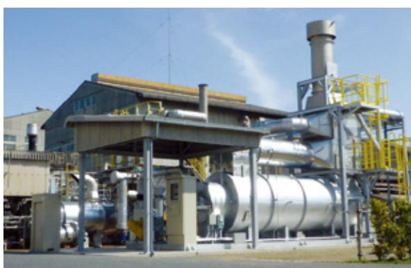
▲2010年3月、乾燥工程で発生するVOCを燃焼して無害化する直接燃焼式排ガス焼却炉を設置しました。
