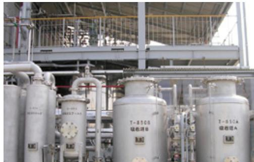
▲不溶性硫黄製造工程で使用する二硫化炭素を回収する装置です。
