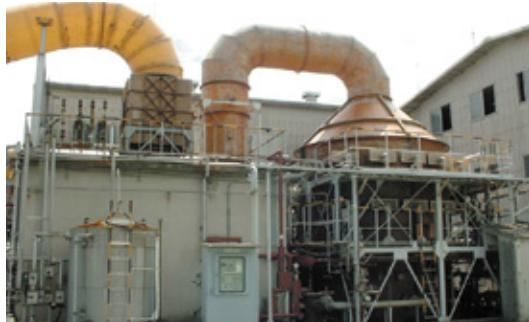
▲塩素化イソシアヌル酸製造工程で発生する塩素を集合させ洗浄処理する設備です。
