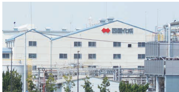
耐震補強を行った丸亀工場製造建屋
