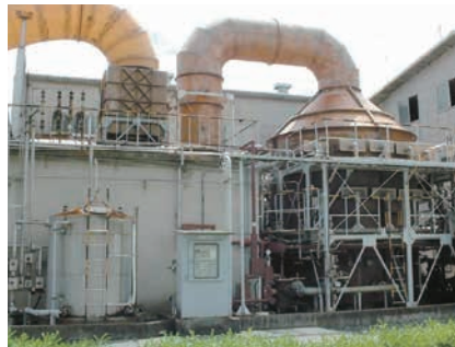
排ガス洗浄処理施設(徳島工場北島事業所)
