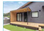
テラス・デッキ
