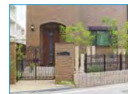
門扉・フェンス
