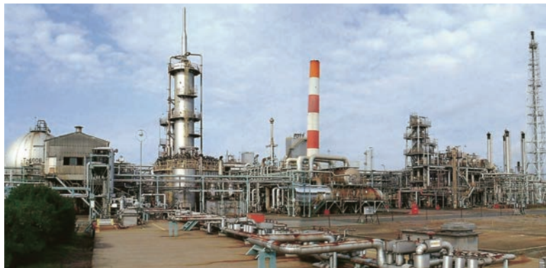
日本硫炭工業(株)大分工場(昭和電工大分コンビナート内)
