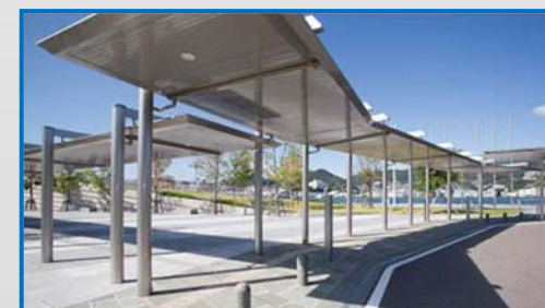
通路用シェルター
