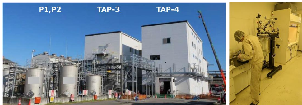
イエロールームを完備した製造プラント（徳島工場）
